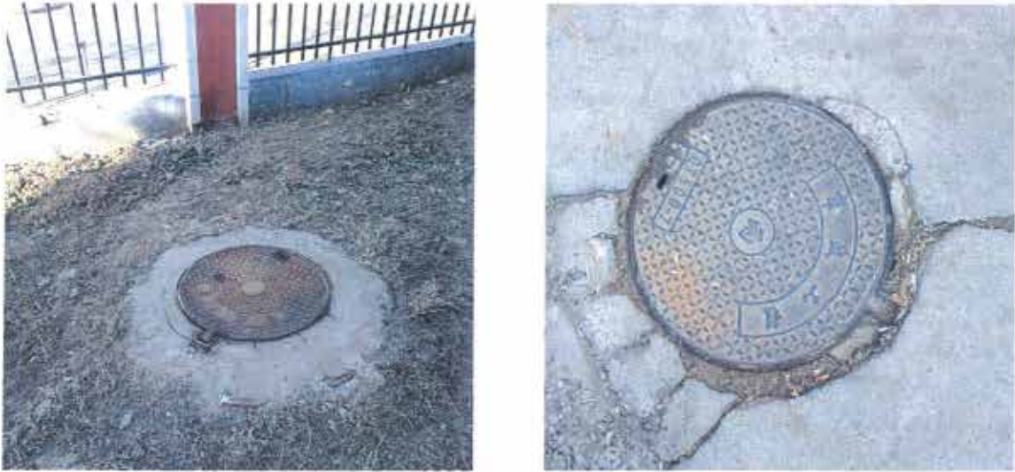
图 4.1-3 项目污水排口及雨水井
