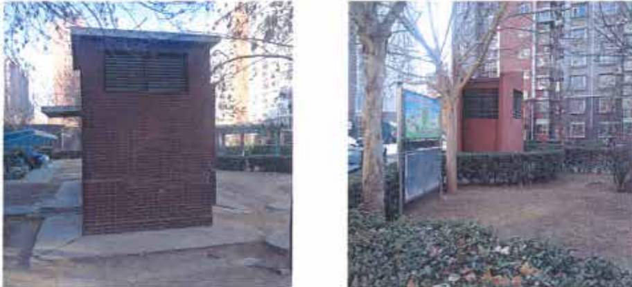
图 4.1-1 地下车库排风口
