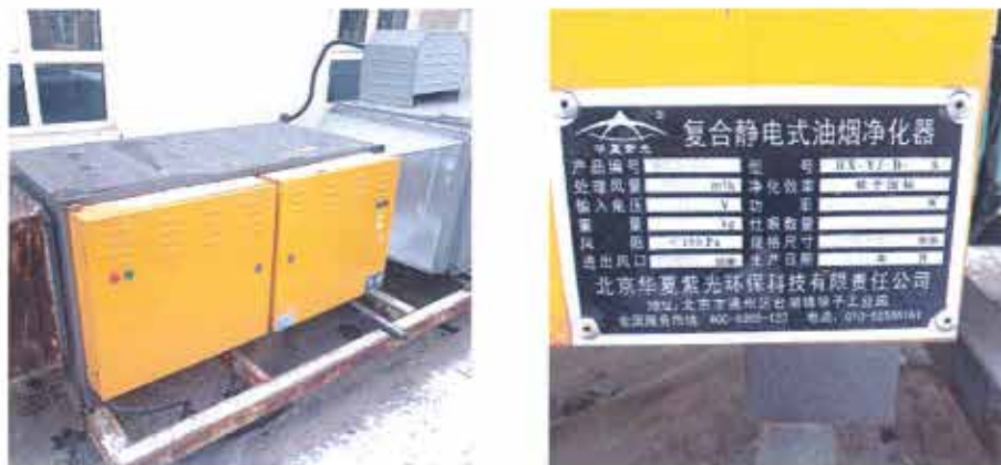
图 4.1-2 幼儿园食堂净化设施
